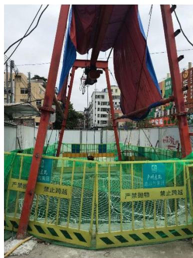
图 1M68 井现场照片
