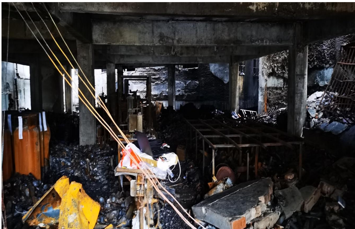
图 17 电源线未采用金属套管保护
