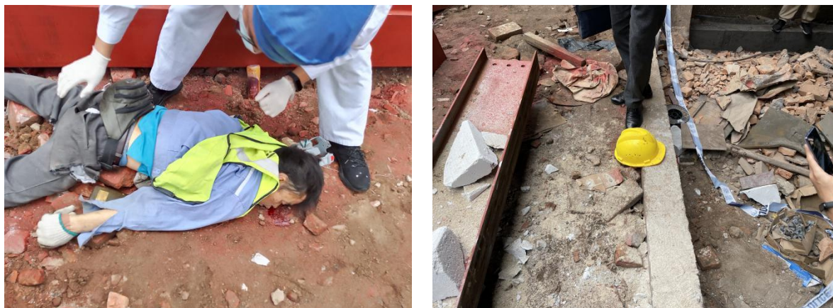
图 3 救援现场和事发后现场勘查情况
