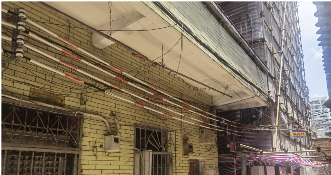
图 19 电力线路在穿入事发楼栋施工脚手架围蔽范围之前的架设情况
