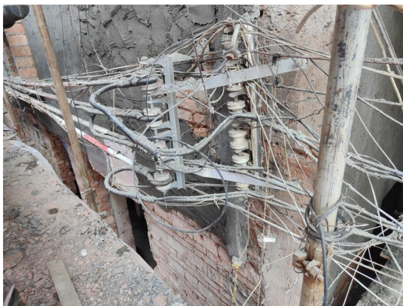
图 22 重点检测区域现场图（西侧外墙靠近西南转角位）
