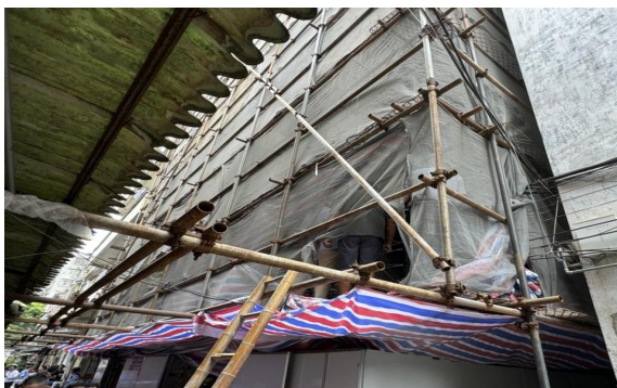
图 2 海珠区素社东街五巷*号外墙脚手架
