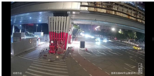
图3 李*明等到过街天桥区域施工
