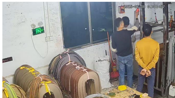
图 16 进行主钩钢丝绳、左防坠器试运行
