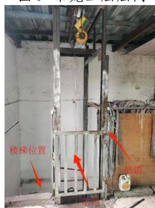
图 11 吊笼五层层门
