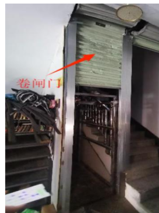
图 7 吊笼一层层门
