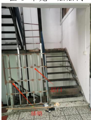
图 10 吊笼四层层门
