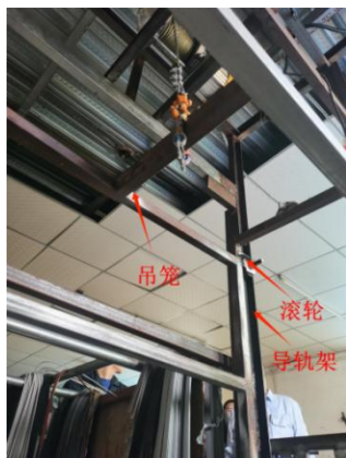
图 6 吊笼运行照片
