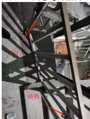
图 8 吊笼二层层门
