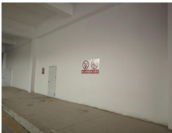
图 1 事故现场原址
