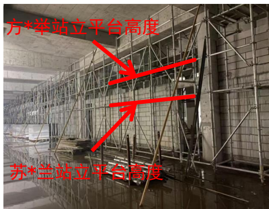
图 2 涉事施工段现场情况
